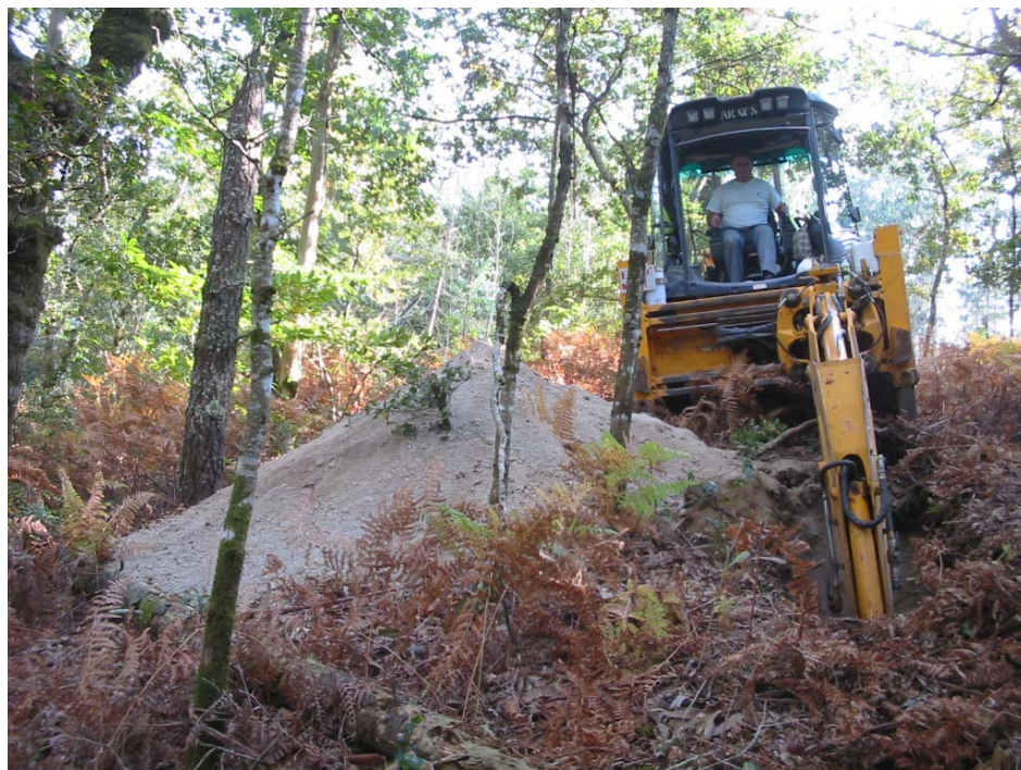
Excavación de calicata en finca 33. Pol. 85.
