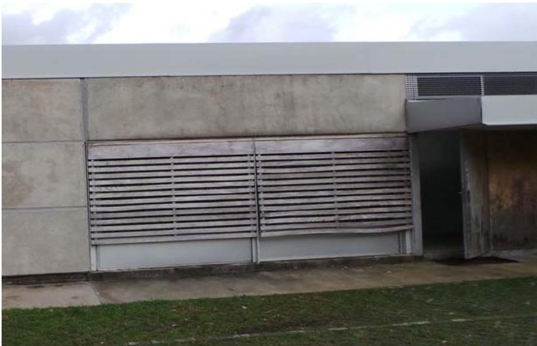
12.- Los tableros de madera de las puertas de la carpintería exterior de acceso a los edificios y de la terraza están muy deterioradas por el paso del tiempo, por el tratamiento dado a la chapa de madera elegida y por los actos vandálicos sufridos a lo largo del tiempo.
