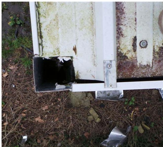
5.- Las vigas de madera lamina del antepecho de la terraza se encuentran podridas y por lo tanto son inservibles, las juntas entre estas vigas y la cubierta son uno de los puntos de mayor entrada de agua al ala destinada a almacén.
