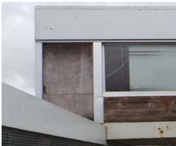
13.- El falso techo de la entrada al gimnasio tiene varias manchas de humedad y está descolgado debido a la entrada de agua que se produce desde la cubierta lo que impide abrir la puerta y poniendo en peligro a los usuarios del edificio.
