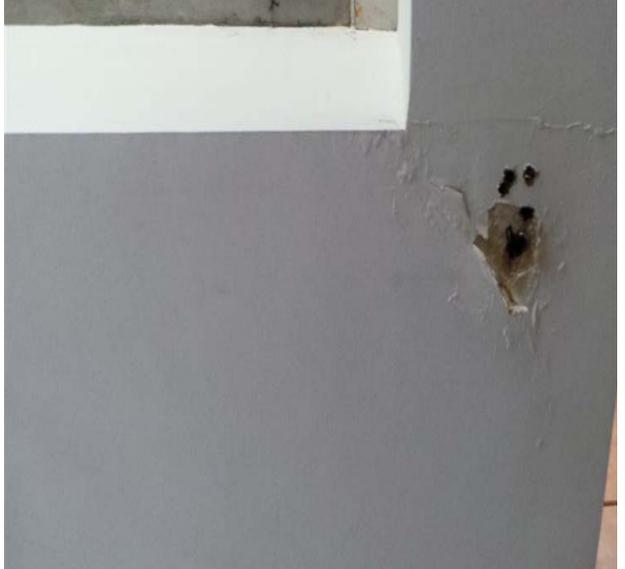
17.- Los techos y paredes del edificio principal se encuentran muy deteriorados por la entrada de agua y el uso, en numerosos puntos hay desprendimientos del enlucido en la parte inferior de los paramentos por ascensión de agua desde la solera por capilaridad a través del ladrillo y del enfoscado.
