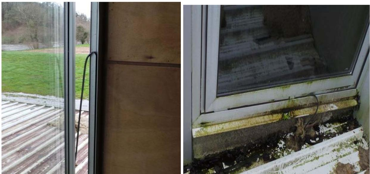
21.- Los tableros de madera vistos tanto de los paramentos como de la carpintería de la oficina se encuentran muy deterioradas por la humedad que tienen debido a la entrada de agua a través de la fachada y de la cubierta y al tipo de madera elegida.
