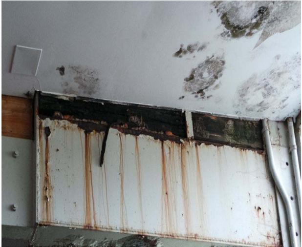
8.- La nave de almacén ventila por la parte superior de sus muros por una rejilla metálica formadas por piezas de acero galvanizado tipo "tramex", sin ningún elemento que impida la entrada directa de la lluvia a través de esta rejilla.
