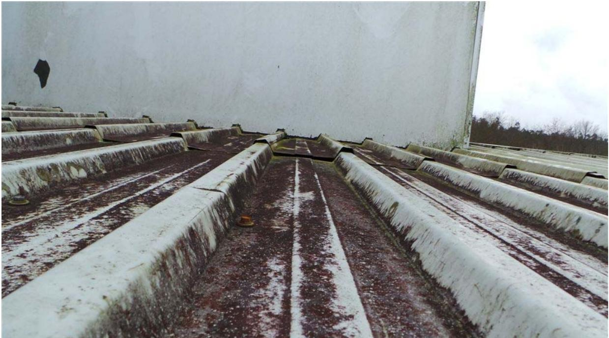
3.- Las juntas de las chapas superiores del cerramiento exterior también están mal ejecutadas, ya que el solape entre ellas no es el suficiente para impedir el paso del agua en la junta. Además algunas, como la esquina del voladizo sobre la entrada, están muy abiertas afectando considerablemente a los falsos techos.
