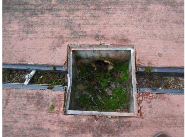
Estado de los solados, barandillas, rejillas arquetas, Instalación de saneamiento...
